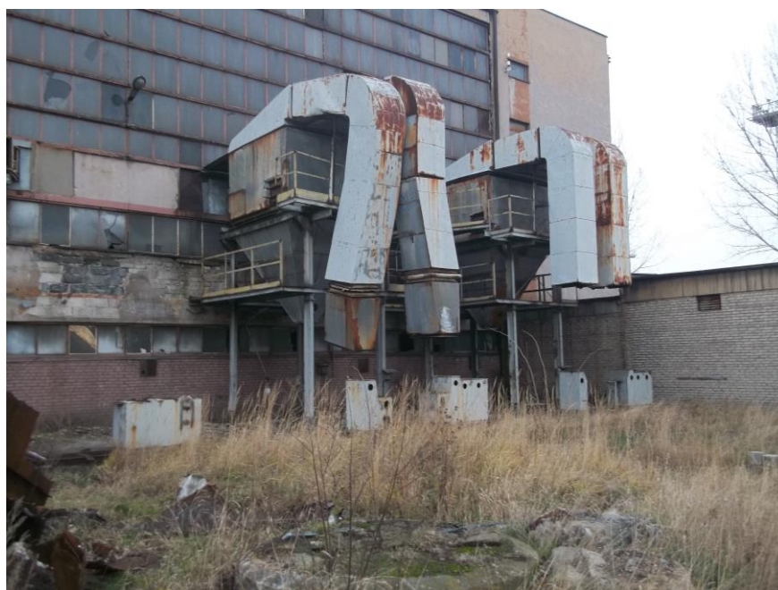
Instalacja odpylania zlokalizowana przy budynku kotłowni. Konstrukcja wsporcza stalowa. Fundamenty żelbetowe. Urządzenia wyposażenia technologicznego z blachy stalowej.
