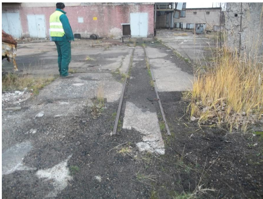
Widoczne pozostałości po torach dla przejazdu wózków z żużłem
