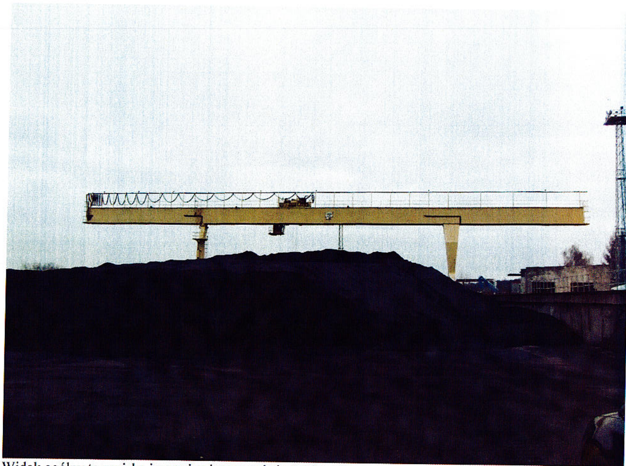
Widok ogólny torowiska i suwnicy bramowej chwytakowej
